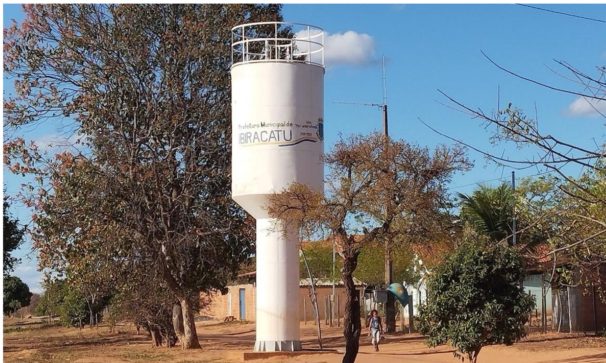
Figura 5.12 - Reservatório utilizado para o armazenamento da água captada do poço subterrâneo.
