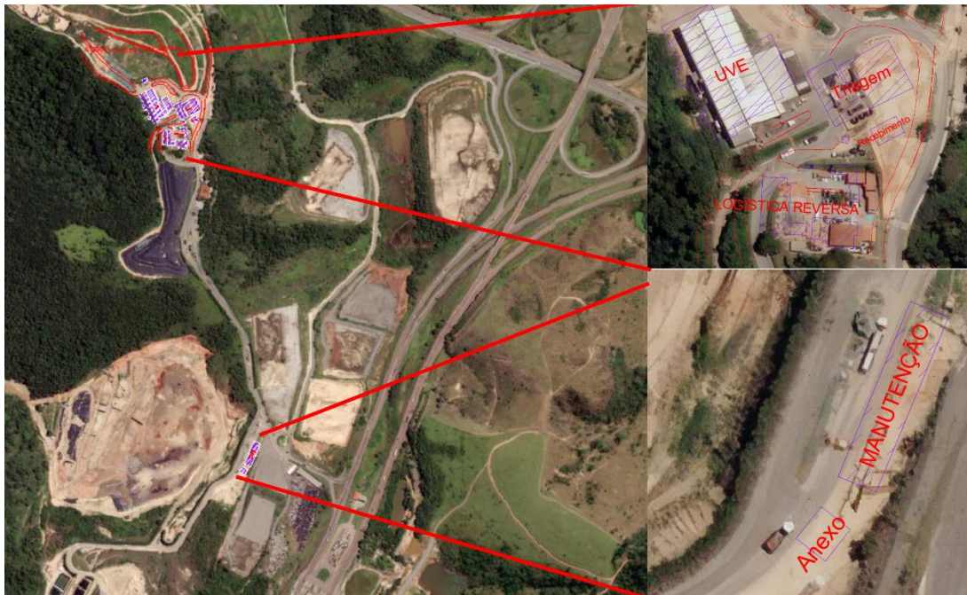
Figura 12 Regiões de captação e reservação de águas pluviais
